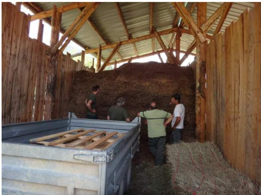
L'entretien de cette chaudière est très simple, il suffit simplement de vider le cendrier 1 à 2 fois par mois. Et bien sûr alimenter le silo (entre 4 et 5 fois par an). En outre c'est une chaudière robuste qui n'est pas très exigeante sur la qualité des plaquettes (taux d'humidité et taux d'aiguilles notamment).
