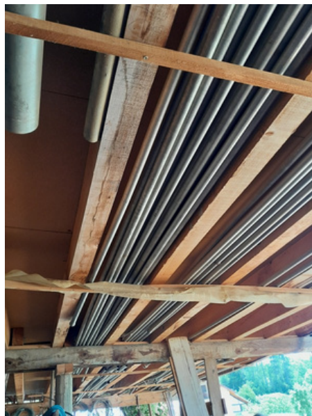
rangement sous le mini hangar sous le toit de l'irrigation PC
