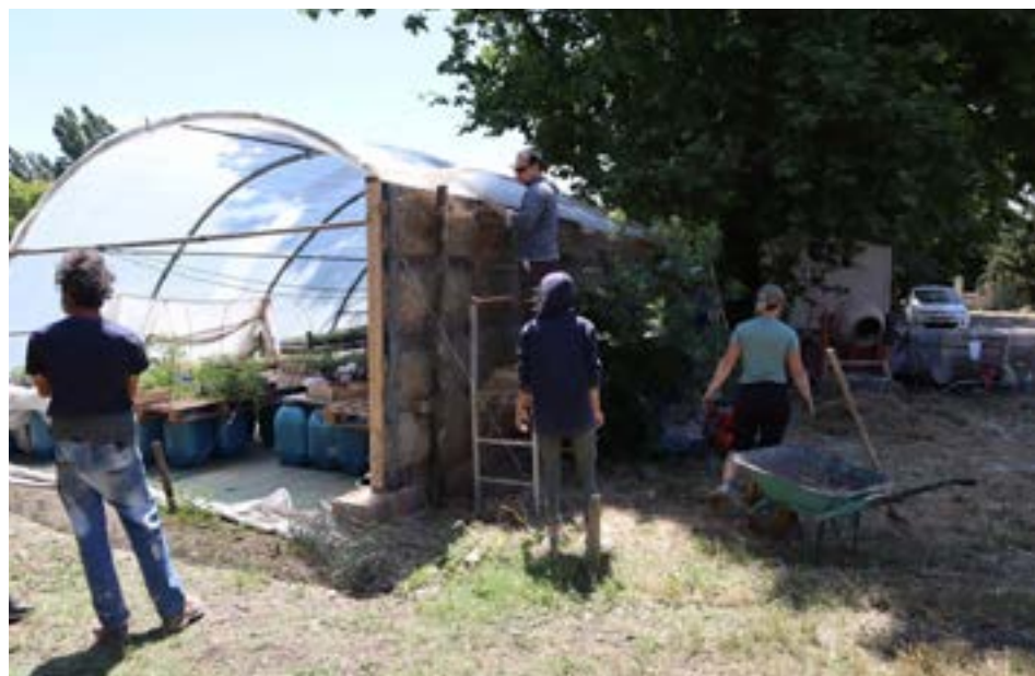
● Chantier participatif de l'APTE : construction d'une serre bioclimatique en terre-paille sur la ferme de Sébastien Elluin, maraîcher à Mollégès [13], en juin 2020
