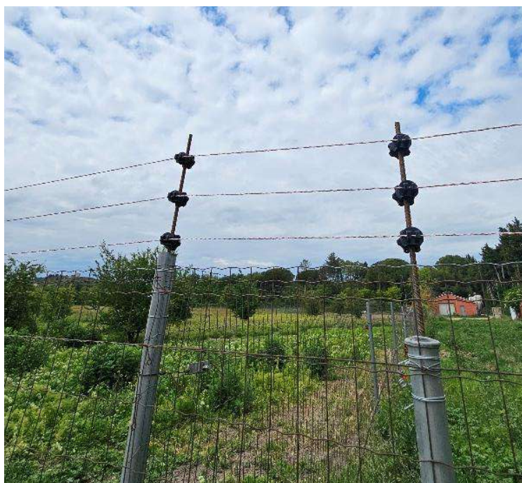
Photo ci-dessus : 3 fils électriques placées en haut d'un grillage d'1m80 de haut, pour éviter que le renard ne puisse passer par-dessus (© Fédération régionale de l'Agriculture Biologique de PACA)
