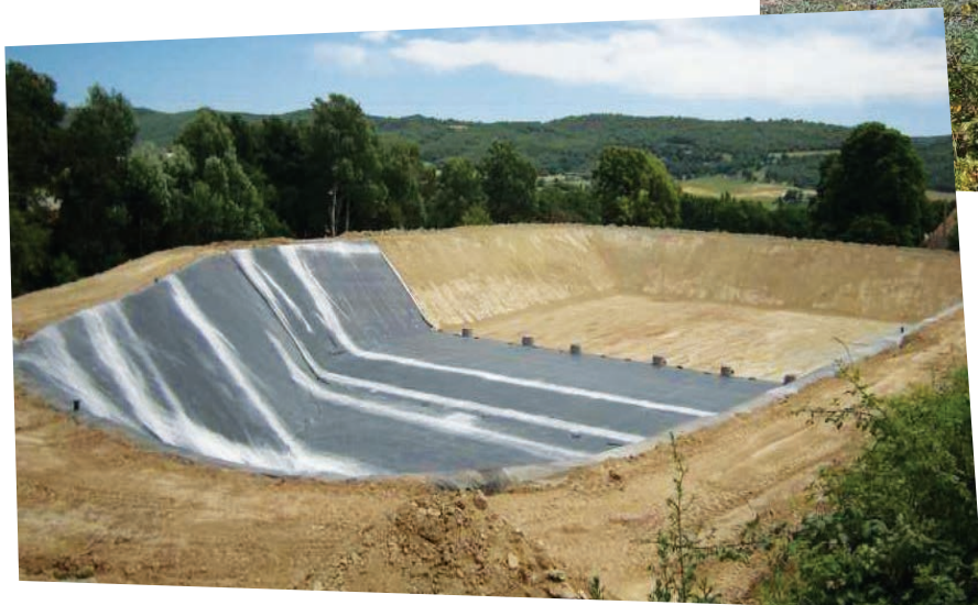
↓ LA POSE DE LA BÂCHE CHEZ JP GOLIATH
